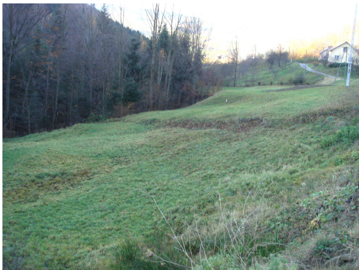
Fot.6 Osuwisko "2" – zachodnia części osuwiska
