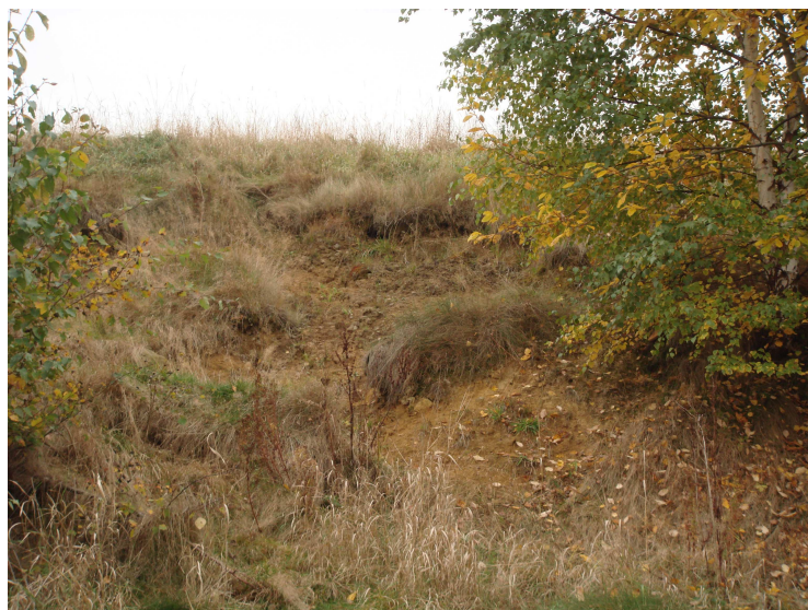
Fot.5 Osuwisko "1" – świeża skarpa osuwiskowa
