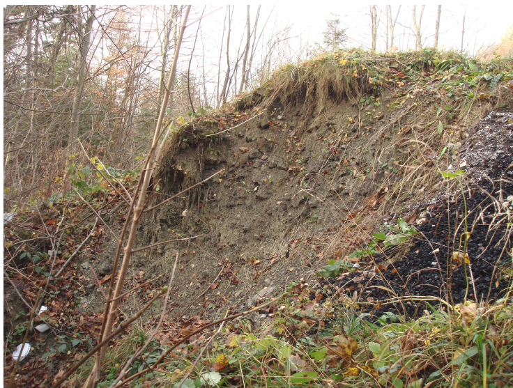
Fot.9 Osuwisko "2" – czoło osuwiska
