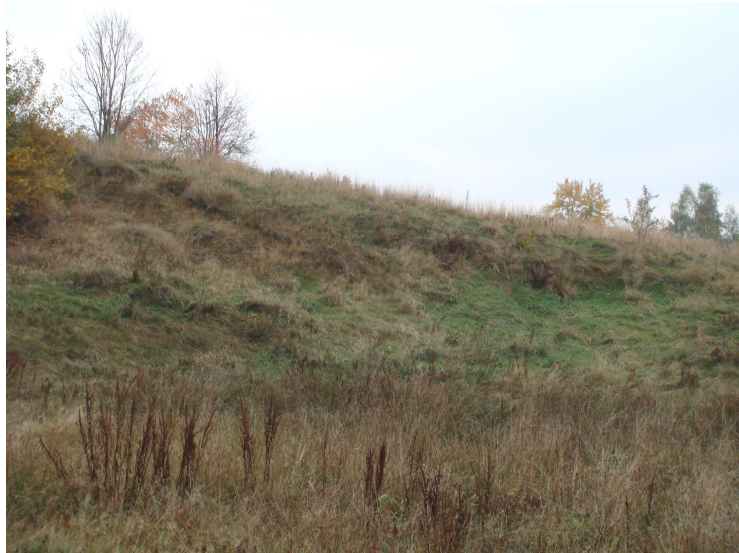
Fot.1 Osuwisko "1" – południowa część skarpy głównej.
