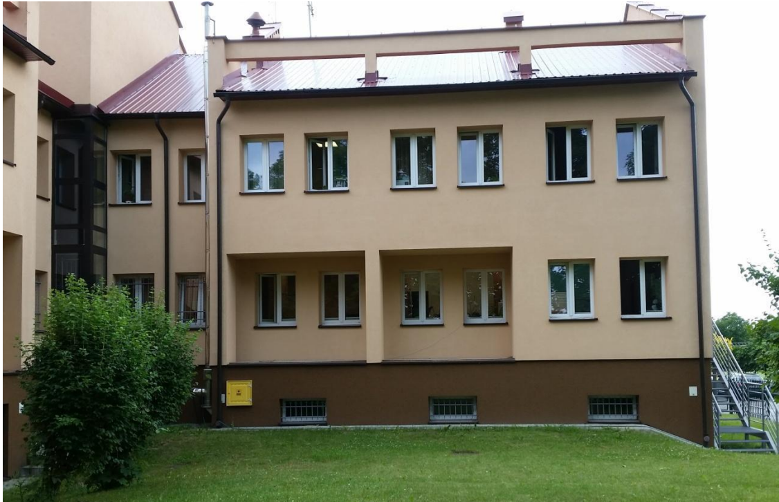
Rys. 4b. Zdjęcie połaci dachowej na której zostanie zamontowana instalacja fotowoltaiczna
