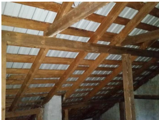
Rys. 2. Stan drewnianej konstrukcji dachowej budynku
