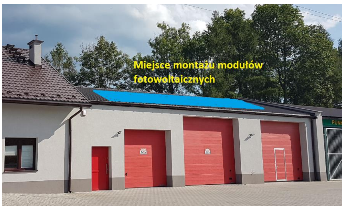
Rys. 5. Połac dachowa na której zostanie zamontowana instalacja fotowoltaiczna
