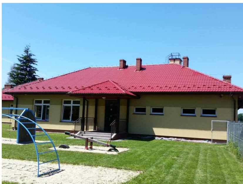
Rys. 6b. Zdjęcie połaci dachowej, na której zostanie zamontowana instalacja fotowoltaiczna
