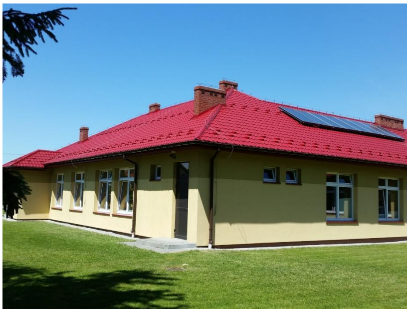
Rys. 6a. Zdjęcie połaci dachowej, na której zostanie zamontowana instalacja fotowoltaiczna
