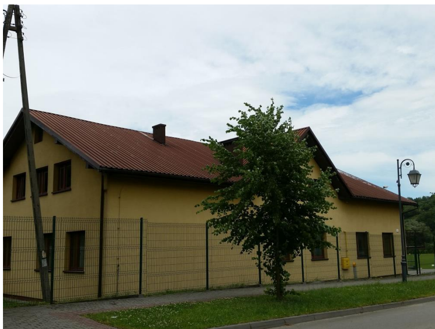
Rys. 6. Zdjęcia połaci dachowej, na której zostanie zamontowana instalacja fotowoltaiczna
