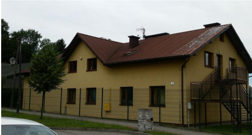
Rys. 1. Budynek zaplecza przy stadionie sportowym
