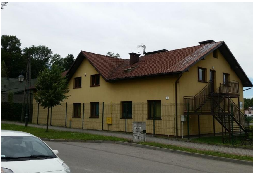
Rys. 5. Zdjęcia połaci dachowej, na której zostanie zamontowana instalacja fotowoltaiczna
