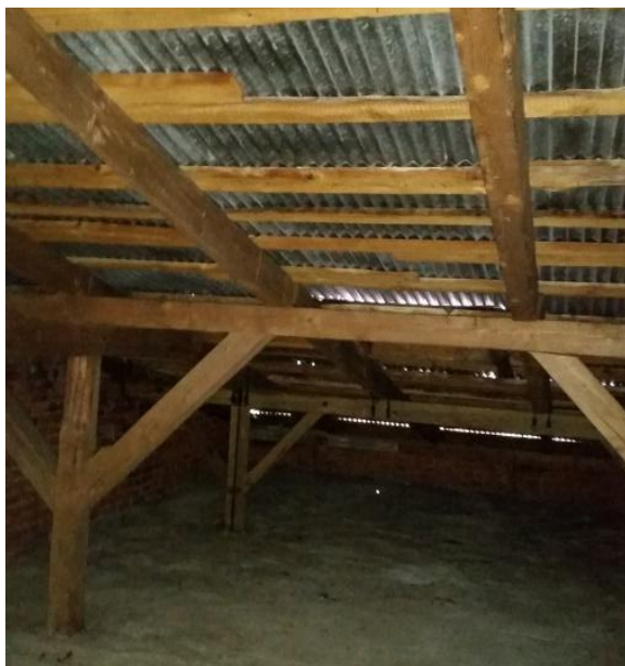
Rys. 2. Stan drewnianej konstrukcji dachowej budynku
