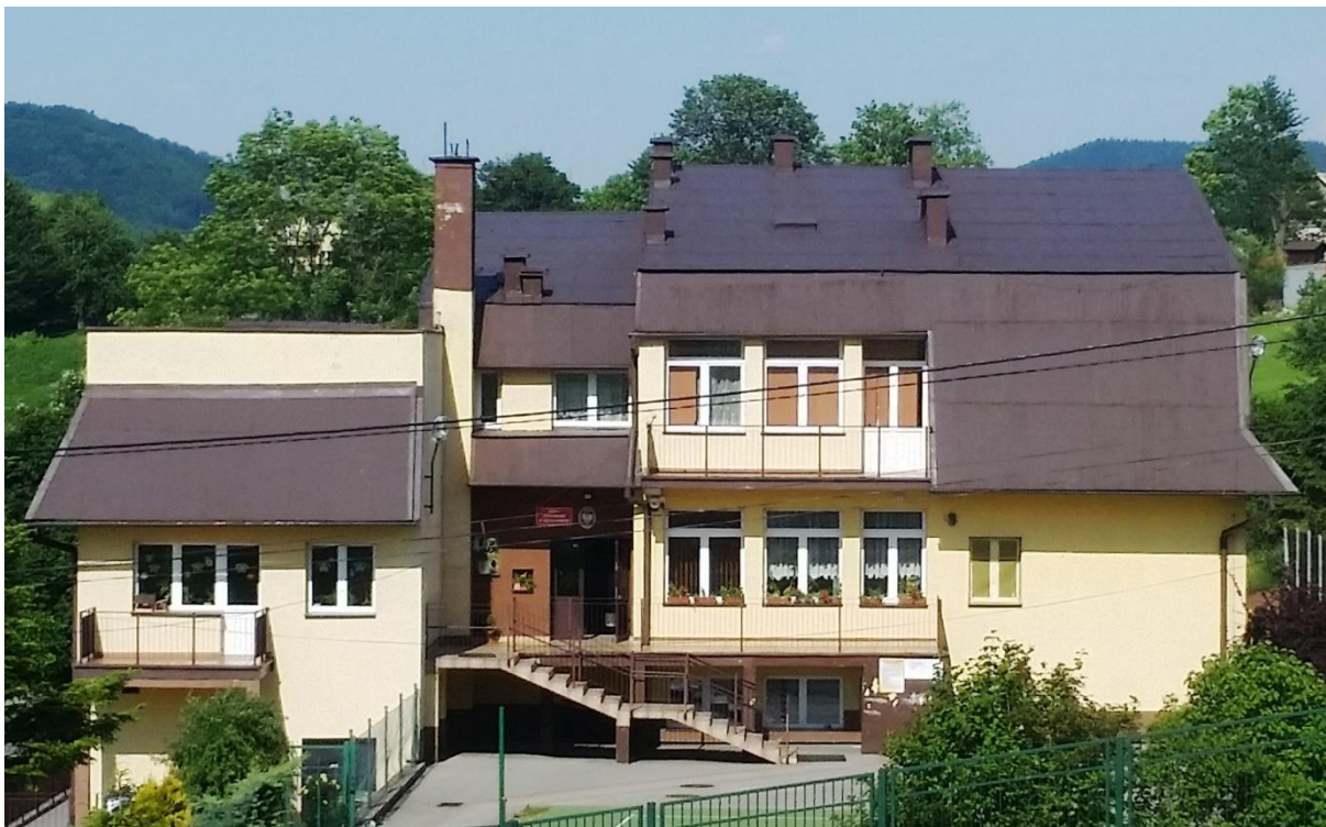
Rys. 1. Budynek Szkoły Podstawowej w Bączej-Kuninie
