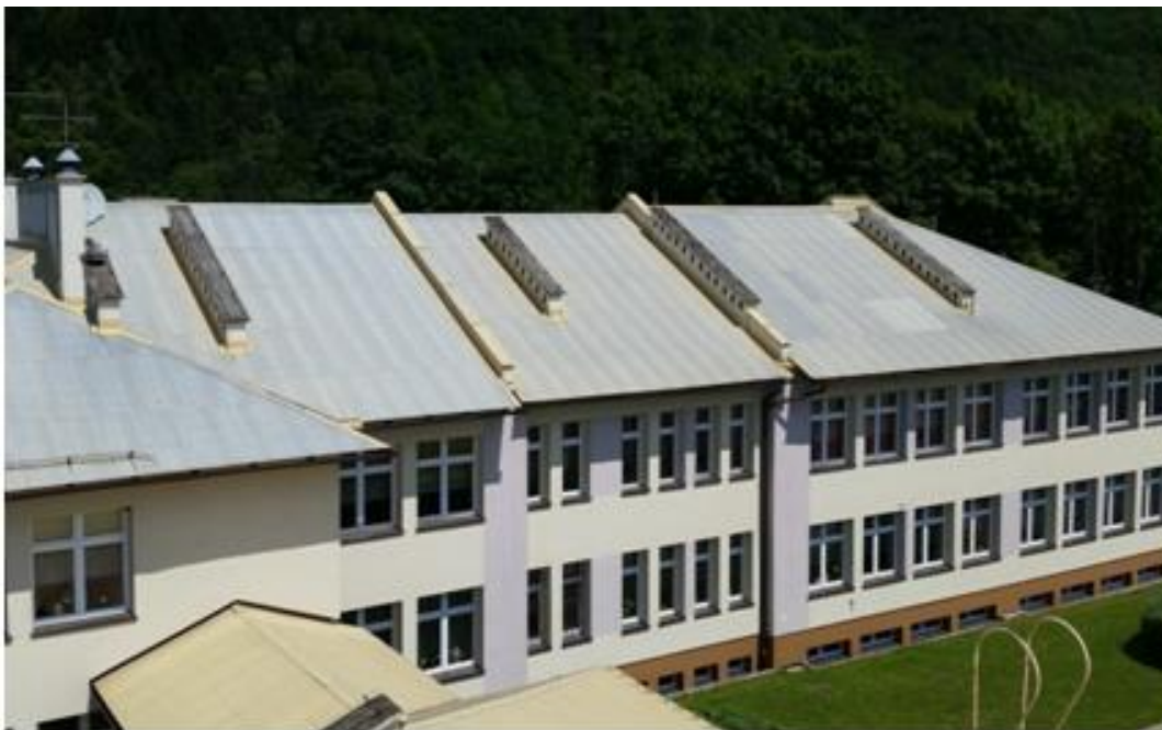
Rys. 5a. Zdjęcie połaci dachowej południowo zachodniej, na której zostanie zamontowana instalacja fotowoltaiczna
