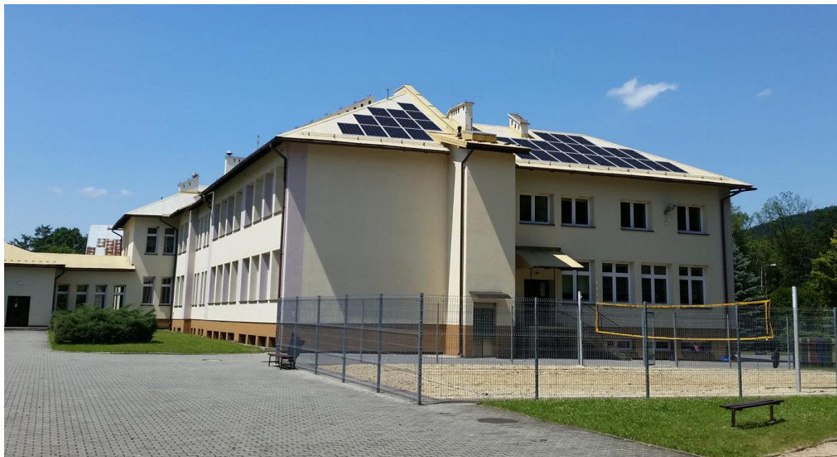
Rys. 9b. Wizualizacja rozplanowania modułów fotowoltaicznych na południowo-wschodniej połaci hali sportowej
