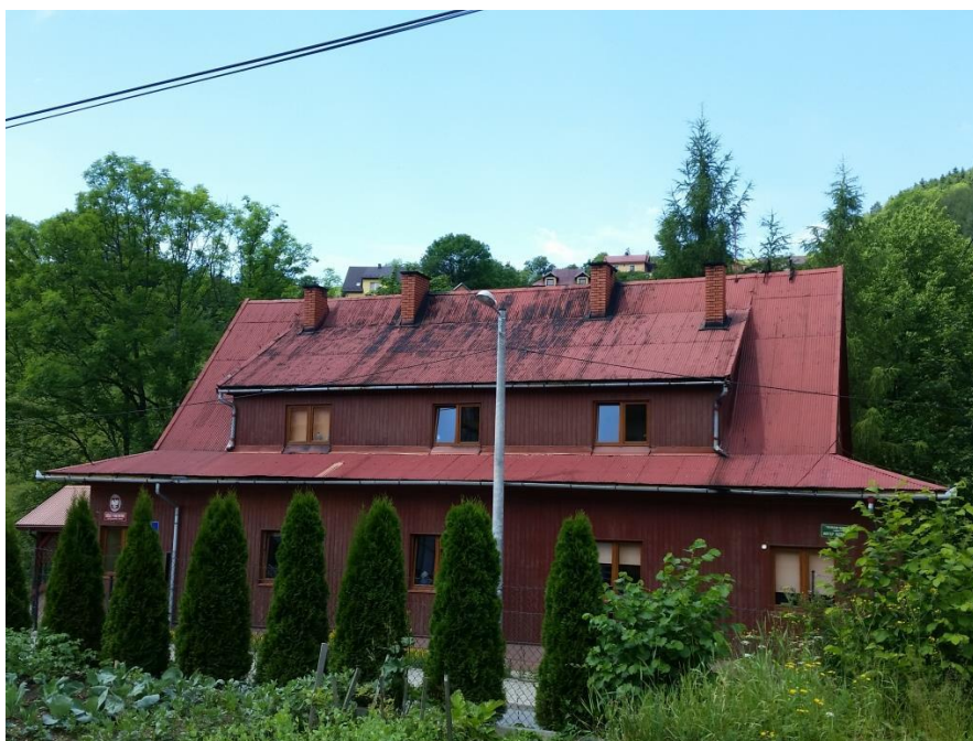
Rys. 5. Zdjęcie połaci dachowej na której zostanie zamontowana instalacja fotowoltaiczna
