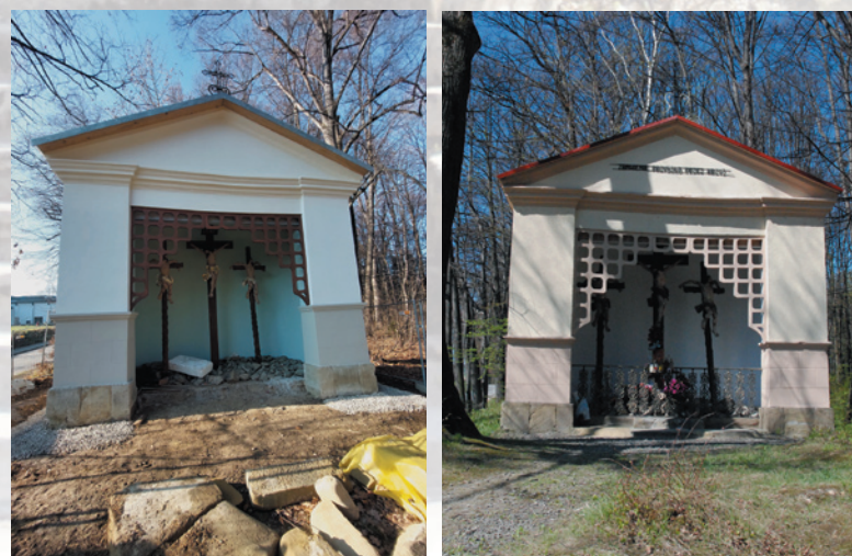
Kapliczka „Trzech krzyży” w trakcie remontu
