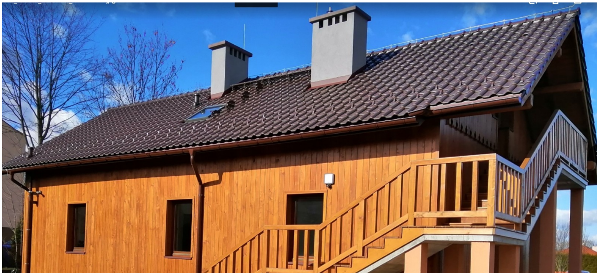
Widok dachu budynku
